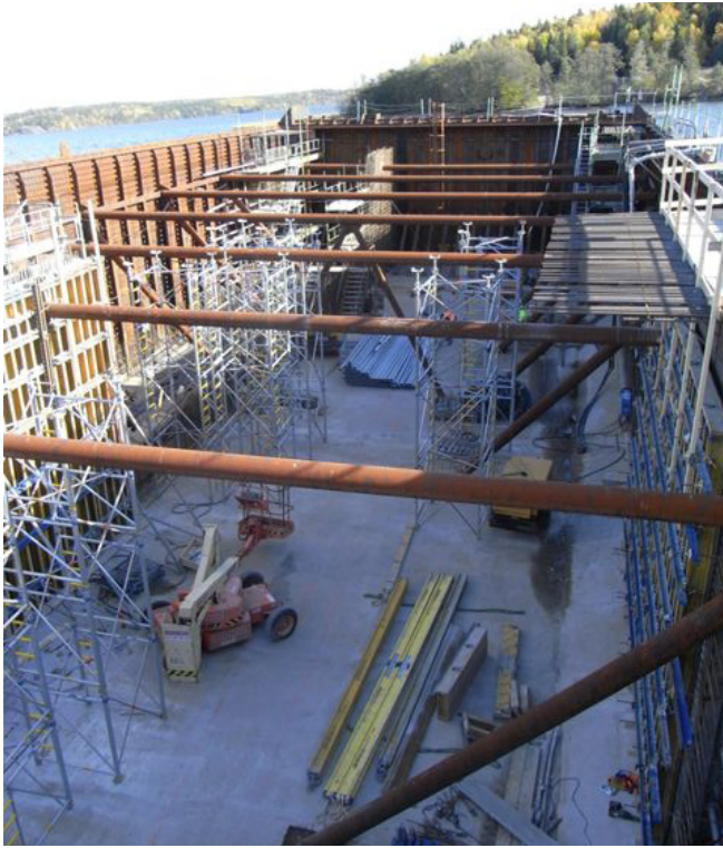
Bottenplatta TE2, Underås Södertälje.
