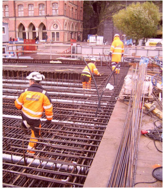
JVS personal förbereder injekteringsslangarna på TE1.
