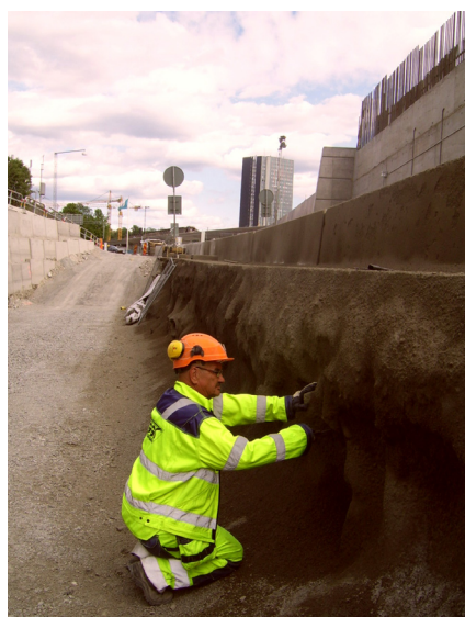
Slätten före och efter betongsprutning.
