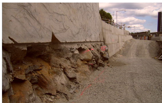
Slätten före och efter betongsprutning.
