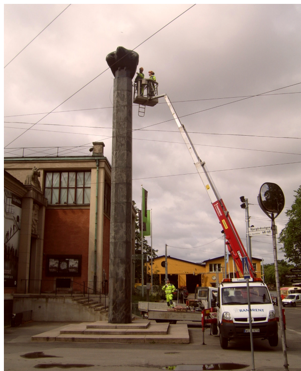
Injekteringslangarna monteras runt skulpturen.
